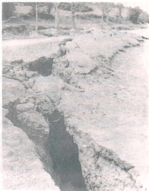
1973 年 2 月炉霍县强烈地震后 地表出现扭曲断裂
