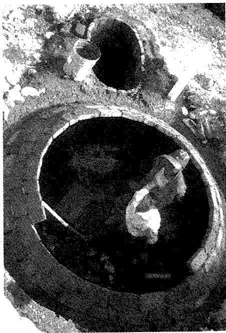
正在建设中的沼气池
